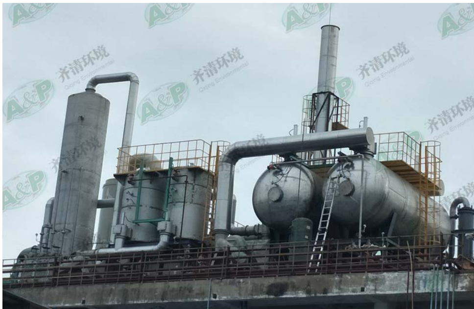
图 7.2-3 颗粒活性炭吸附-脱附再生设备图片
